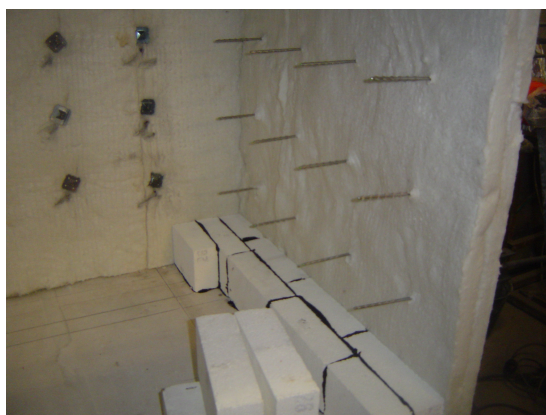
FIGURE 11 – premières couches de fibre
