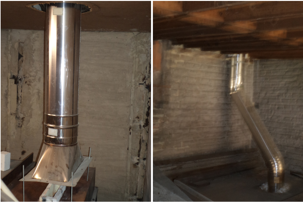
FIGURE 15 – conduit de fumée
