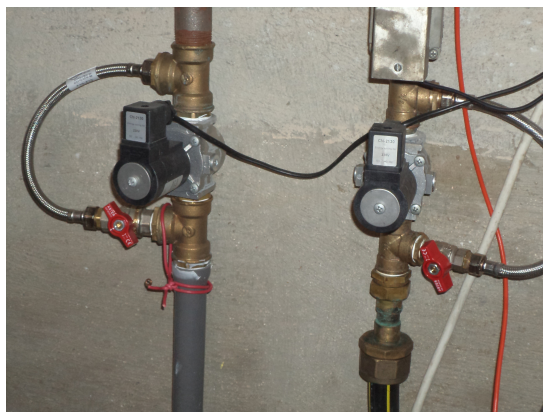
FIGURE 21 – électrovannes et dérivations
